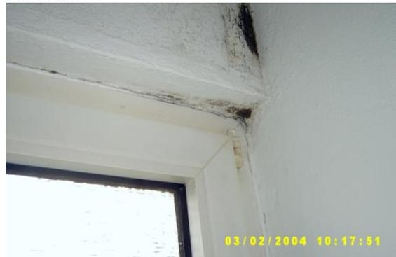
*Geometrische Wärmebrücke, gepaart mit einer Stoffbezogenen mit der Folge erhöhtem Temperaturabfluss, niedrigen Oberflächen, Kondensat und letztendlich Schimmel; Foto: Brandhorst*
